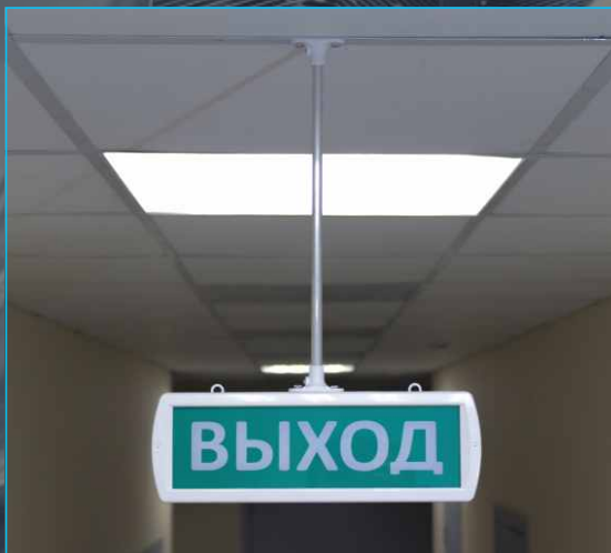
«ТРУБКА» К ПОТОЛКУ
